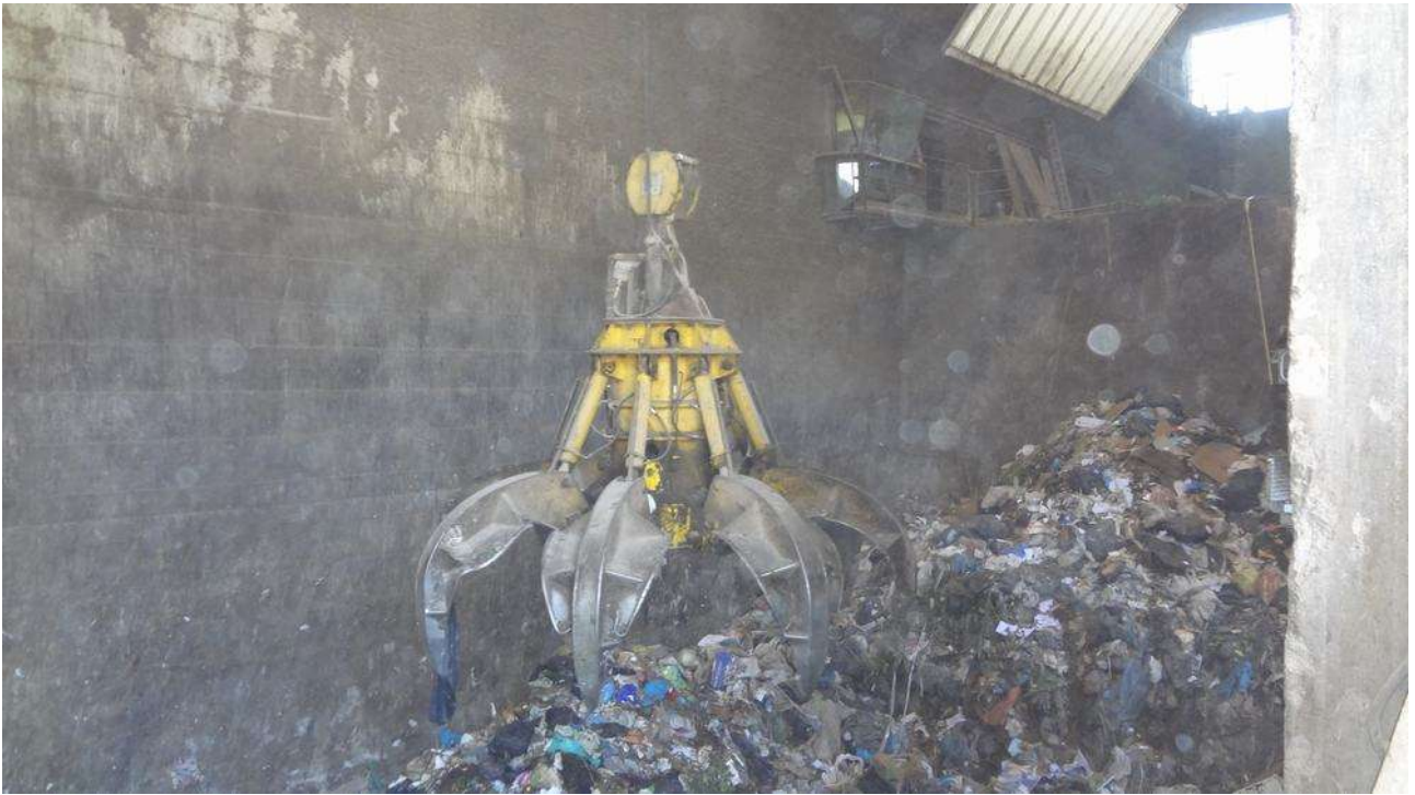
Relluce, 18/09/2013: vasca di accumulo dei rifiuti dalla quale è stato prelevato il campione da sottoporre a quartatura
